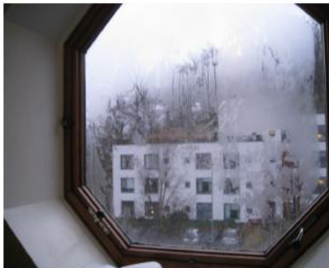
Kondens på vindu blakk A
